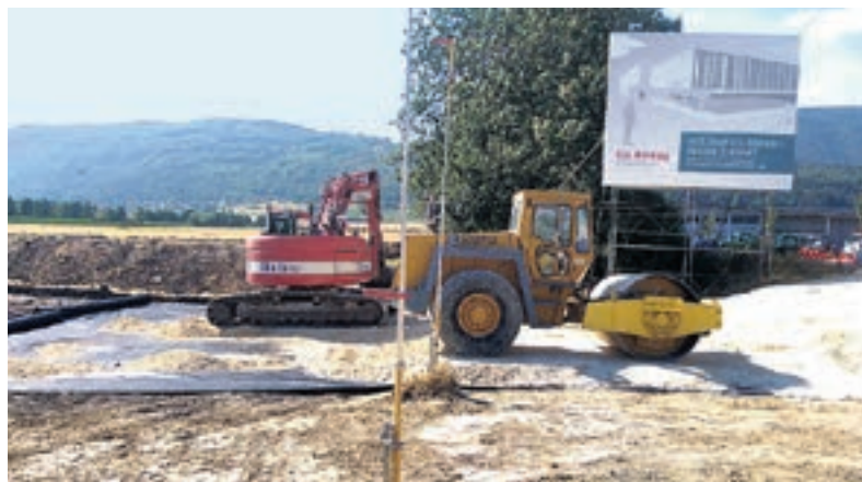
Baustelle Lengnaumoos: Geplant sind 300 neue Arbeitsplätze.
